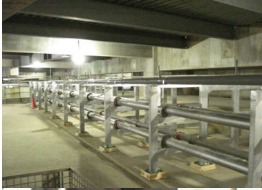
配管ラック 溶融亜鉛メッキ施工
