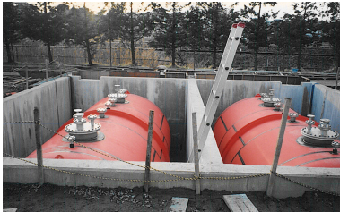
地下埋設貯蔵タンク
