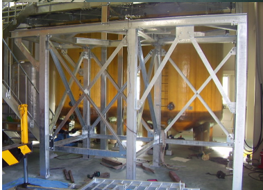
立架台 溶融亜鉛メッキ施工
