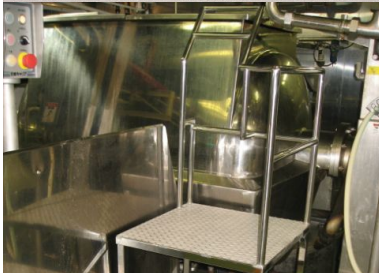
食品工場 点検架台
