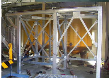
■ 立架台 溶融亜鉛メッキ施工
