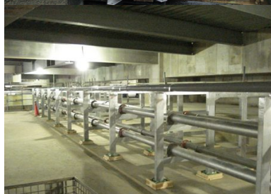
■ 配管ラック 溶融亜鉛メッキ施工
