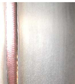
■ タンクのT I G溶接ビード
